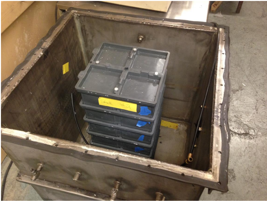
Altitude (Battery Stack)
