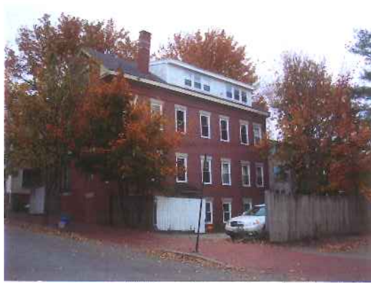
29 Park (abuts site)
