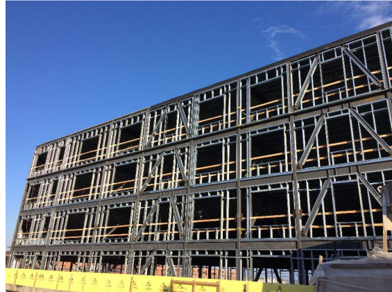
Exterior wall stud infill
