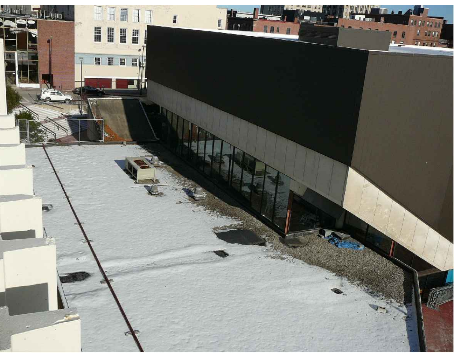
E1 SITE PHOTO
