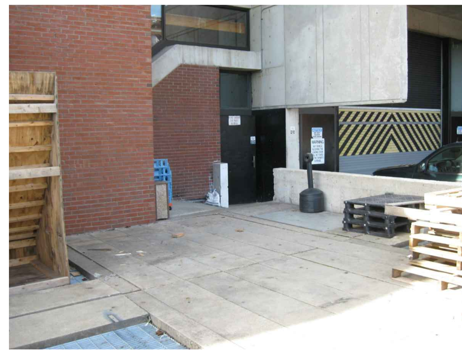
E10 SITE PHOTO
