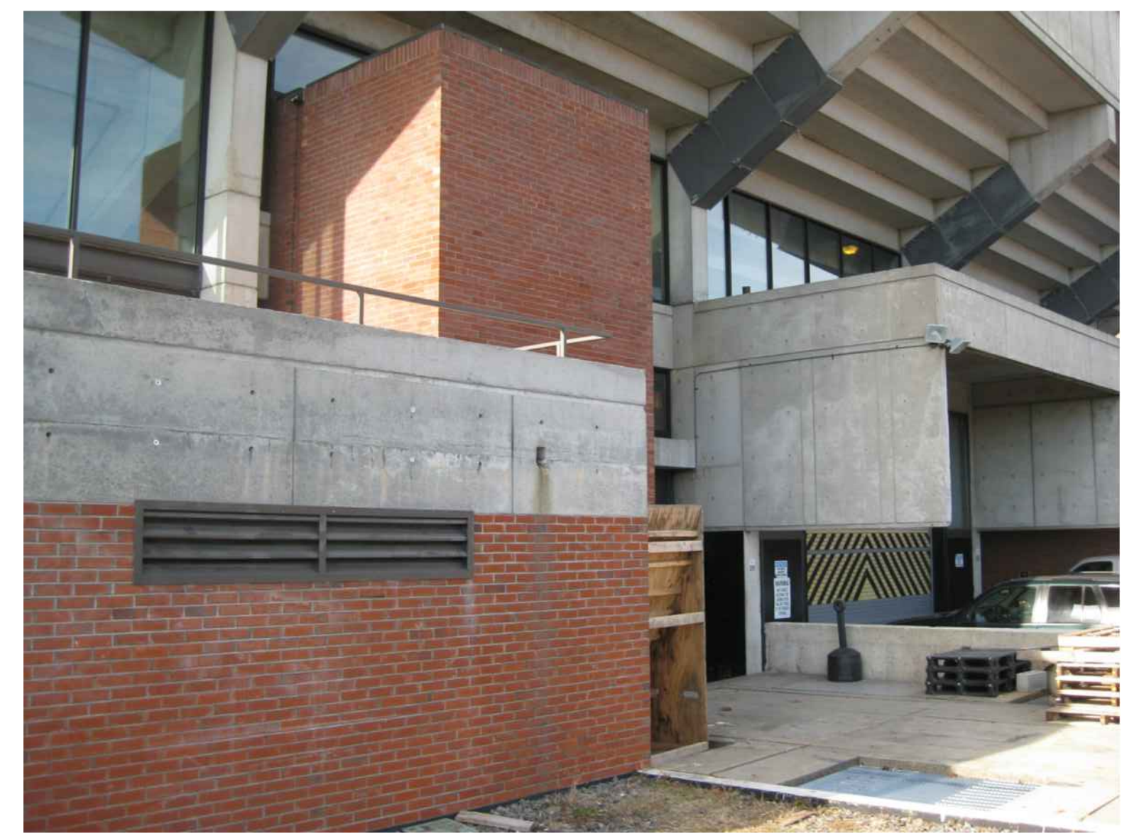
E14 SITE PHOTO
