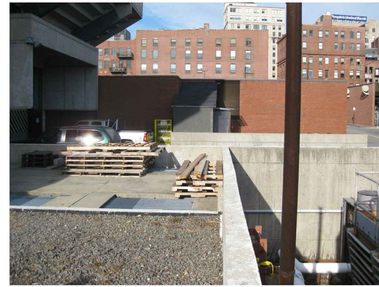
E5 SITE PHOTO
