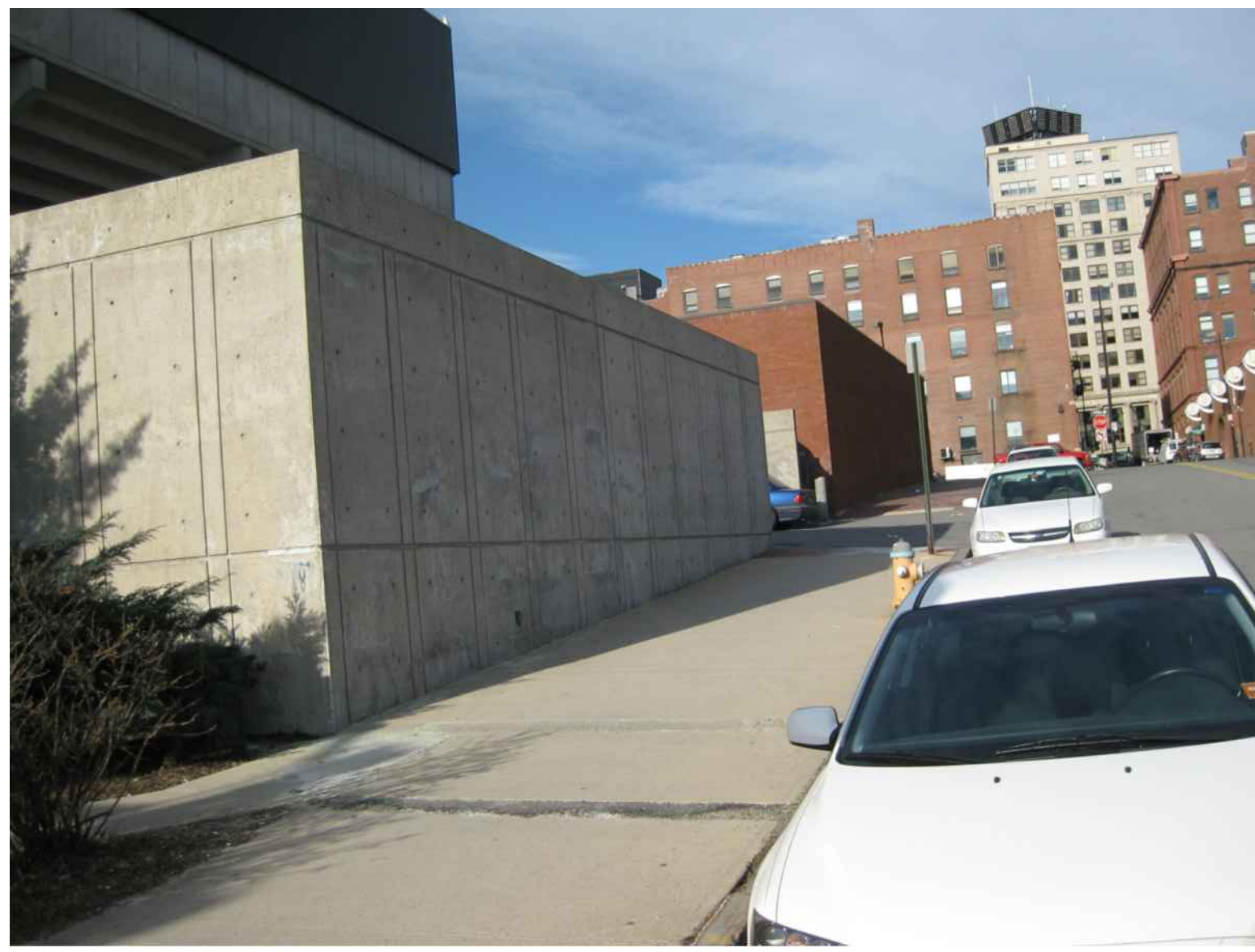
E1 SITE PHOTO
