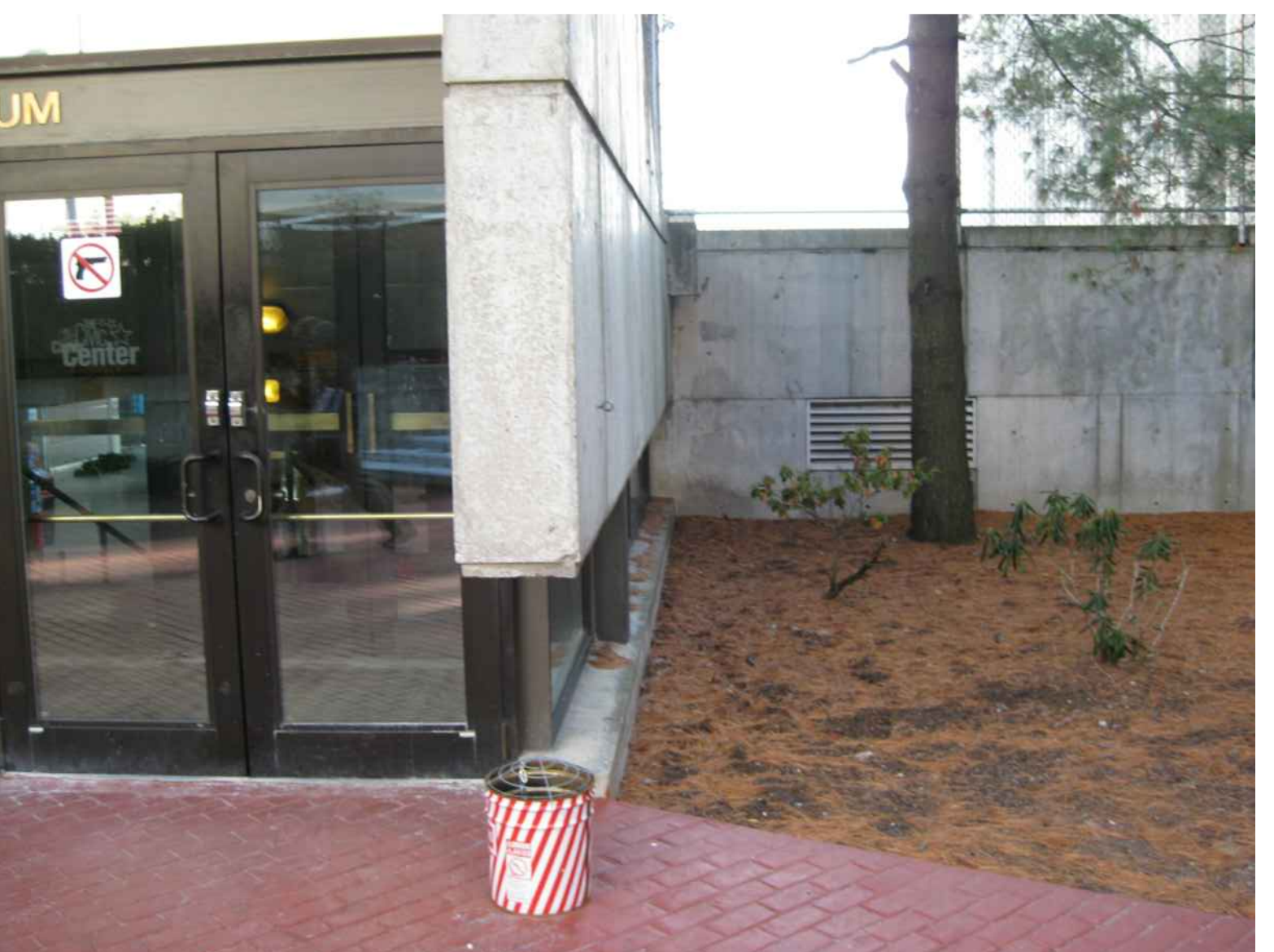
E1 SITE PHOTO
