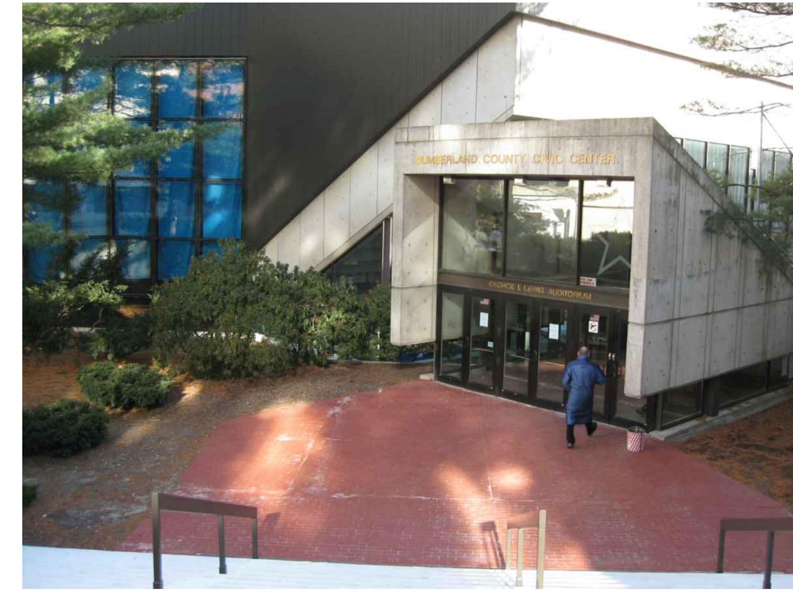
E14 SITE PHOTO
