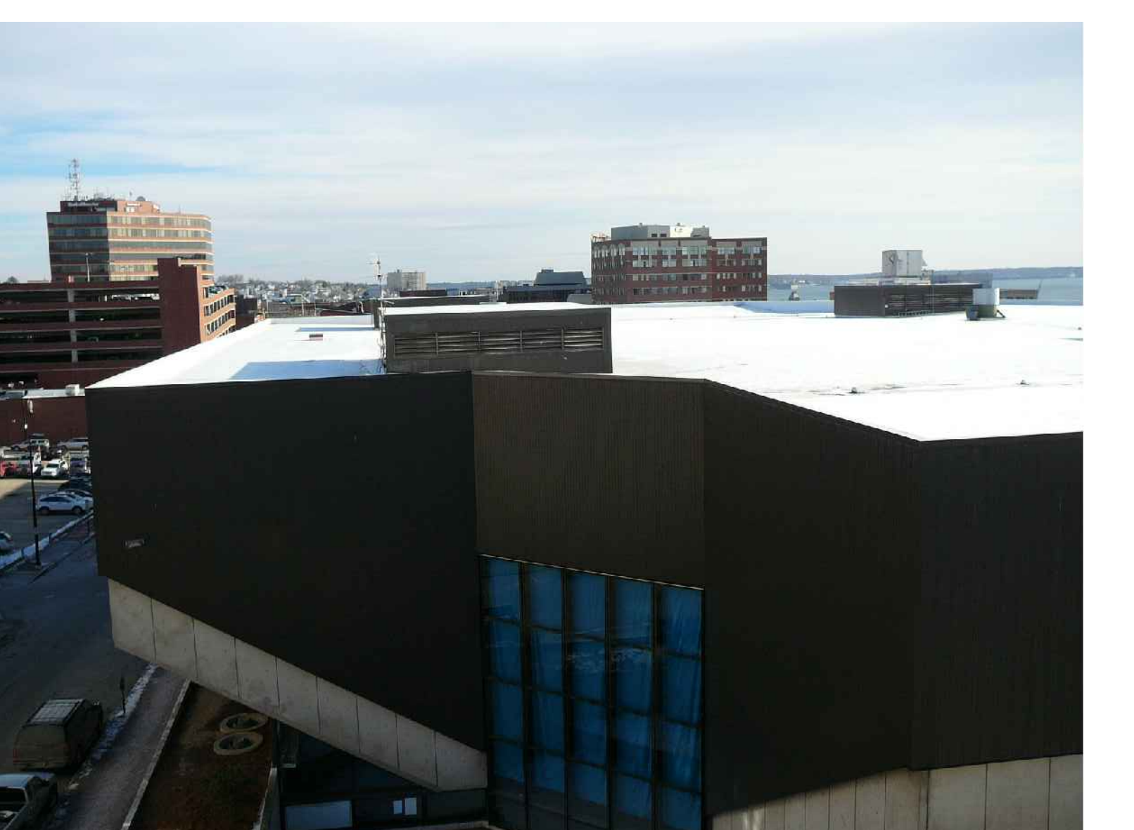
E14 SITE PHOTO
