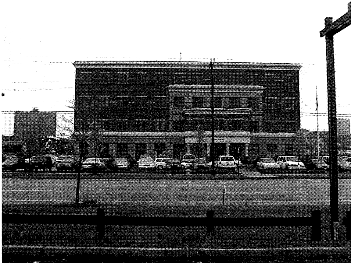
D. H. S. BUILDING ON MARGINAL WAY
