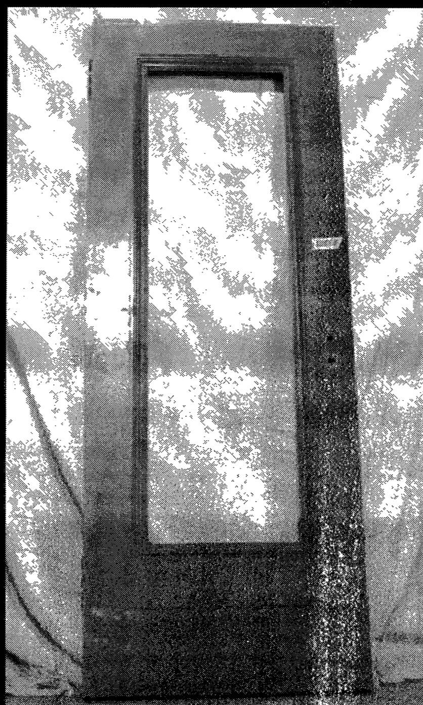
FR DOOR # 14 DOOR THICKNESS 1-3/4" DOOR WIDTH 32" DOOR HEIGHT 83"
