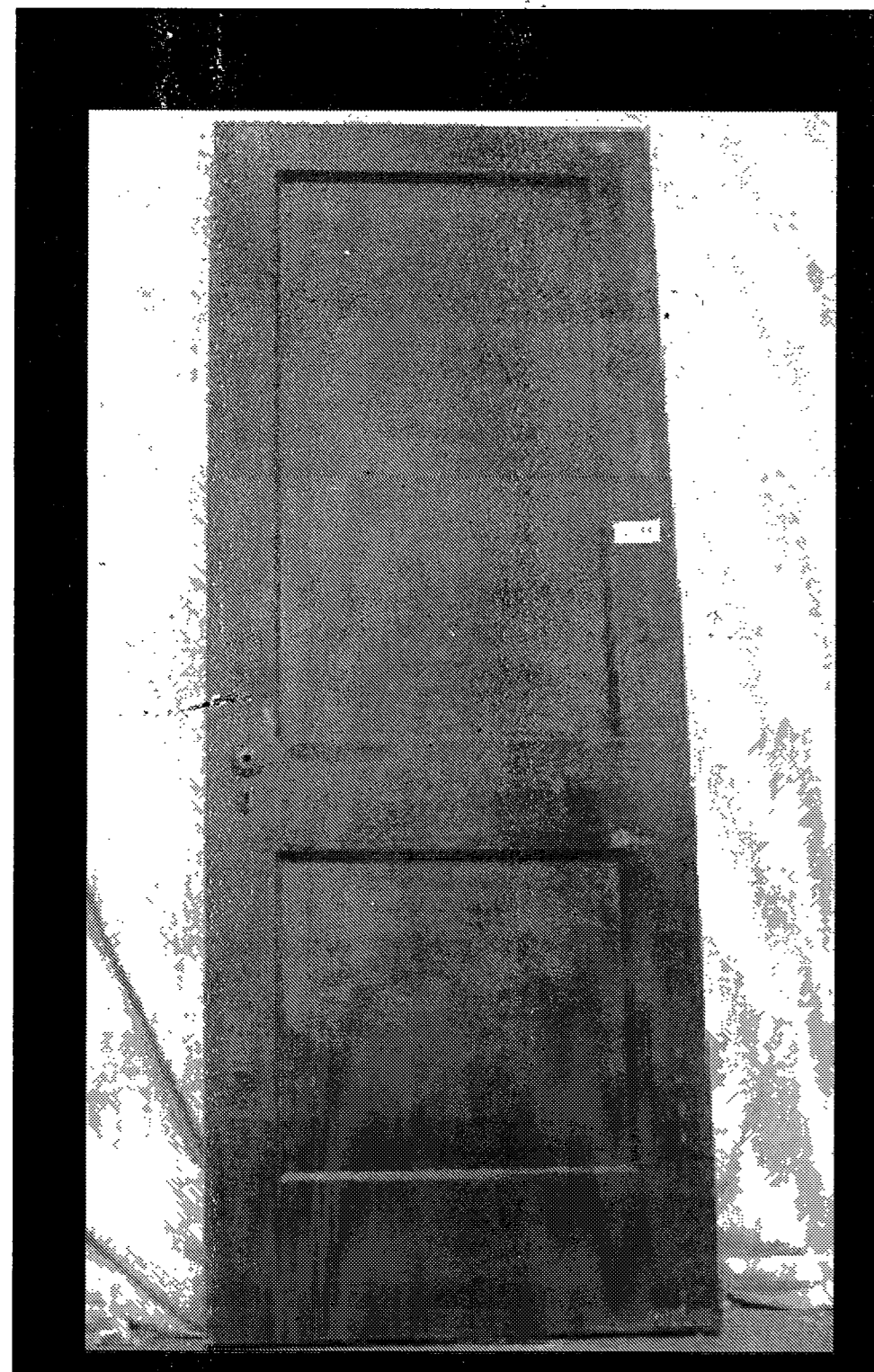
FR DOOR # 21 DOOR THICKNESS 1-3/4" DOOR WIDTH 30" DOOR HEIGHT 79-1/4"
